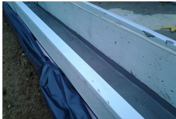
Möglichkeiten für eine Kondensatentwässerung aus der Rinne - direkt verbunden mit einem Rinnenablauf in das Ausgleichsbecken oder nachher einen Schlauch einlegen.
