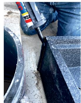
5. Gehrungen und Schrauben mit Montagekleber verschließen
